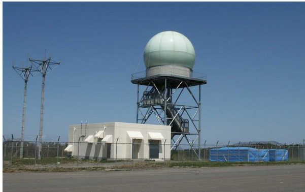
SSR (二次監視レーダー装置)
